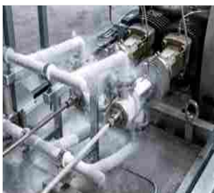
Pompe criogeniche LNG ad
